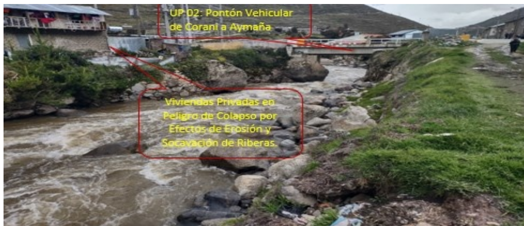
Imagen 02: Se observa en peligro de socavación de riberas y que afecta directamente a la infraestructura pública del pueblo y la unidad productora que es el
