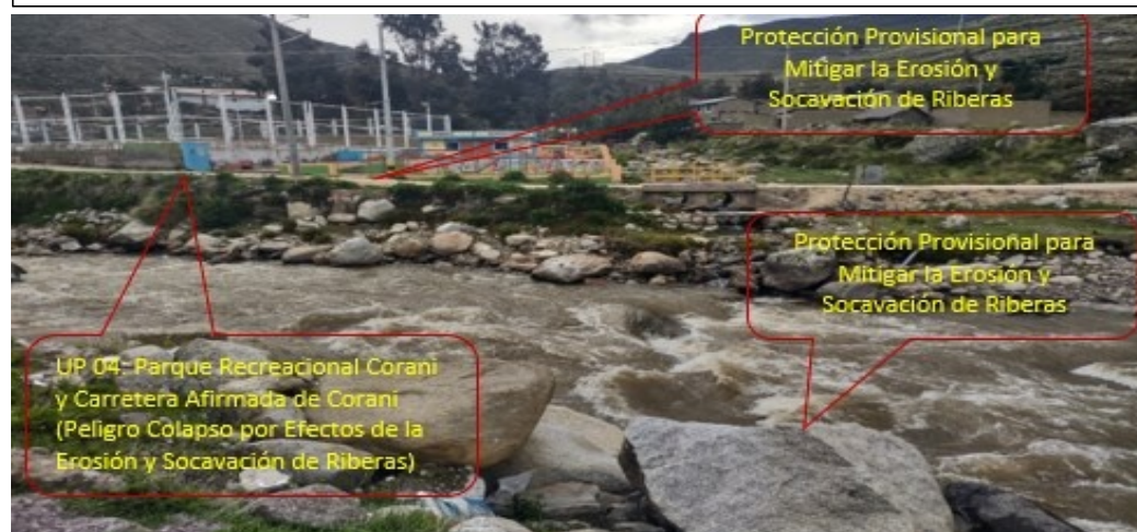
Imagen 04: Se observa en peligro de erosión y socavación de riberas y que afecta directamente a la infraestructura pública del pueblo y a la unidad productora del parque recreacional y camino
