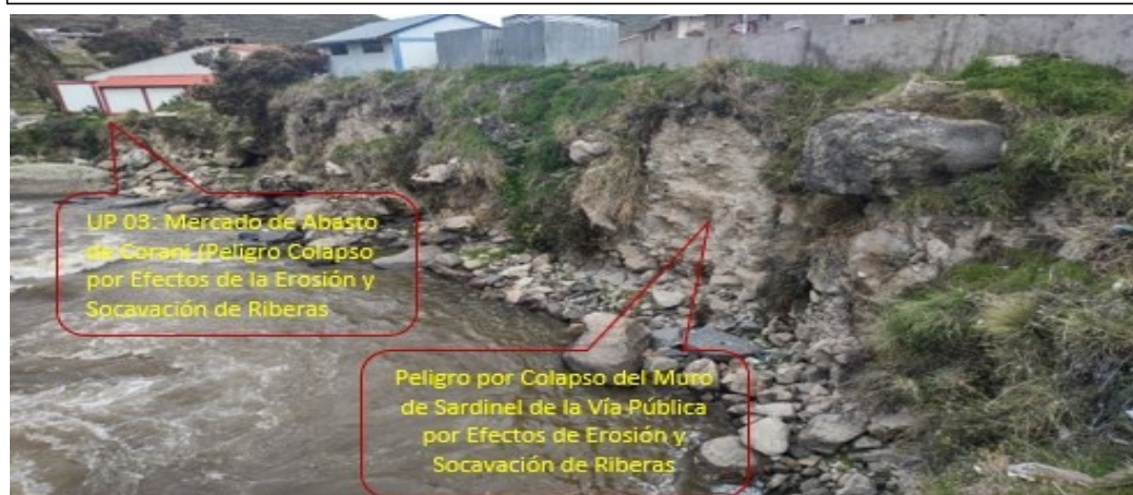
Imagen 03: Se observa en peligro de erosión y socavación de riberas y que afecta directamente a la infraestructura pública de l pueblo y a la unidad productora
